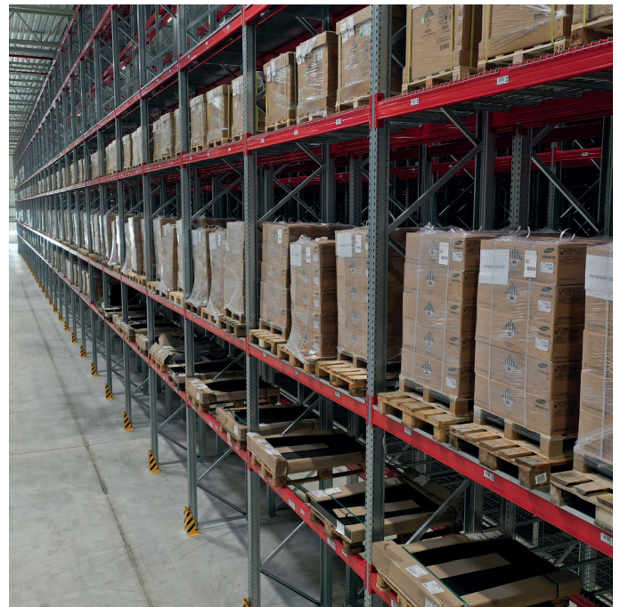
Hochmoderne Lagerflächen für Lithium-Ionen-Batterien bei Hartmann International
