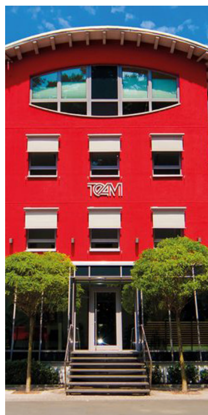
Firmensitz der TEAM GmbH mit der markanten roten Front. – Foto: Team GmbH
