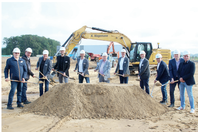
Eröffneten offiziell die Baustelle am neuen Standort (v.l.): Klaus-Jürgen Becker, Christian Schlieff, Markus Bergedieck, Philip Klasing, Andreas Gartemann, Siegbert Wortmann, Dirk Speckmann, Michael Meyer-Hermann, Ulrich Nowatzki, Jens Steinmann und Frank Rottwilm.
