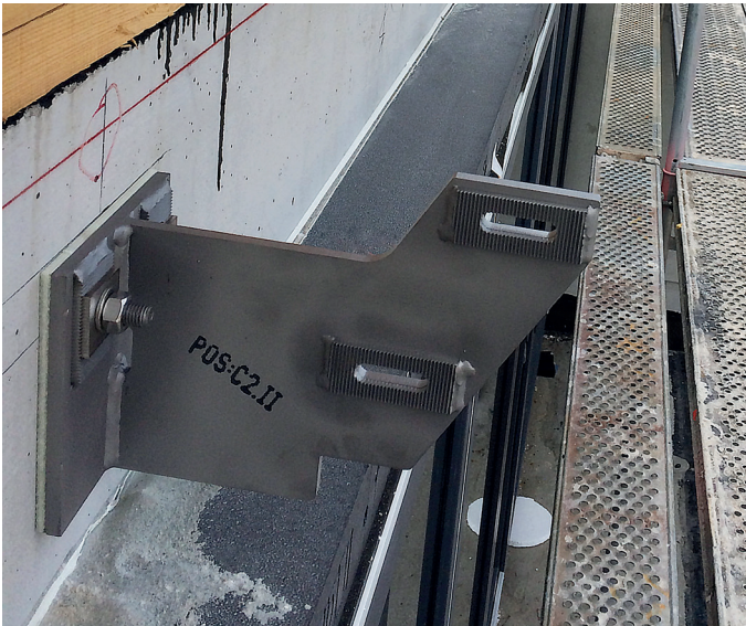
Sondergefertigte Schwerlastbefestigungen mit MOSOTherm unterfüttert.
