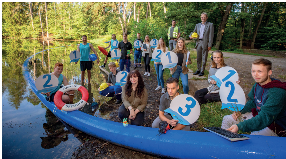
Mit einem sog. Inlinersystem, sanieren die Stadtwerke bis September 2021 die Trinkwasserleitung am Donoperteich. Von links nach rechts: Nils Diekmann, Tim Weber, Toni Lause, Daniel Isaak, Felix Kortekamp, Thordis Wangemann, Enrico Thissen, Jacqueline Stämmeler, Josephine Milena Jacobi, Jürgen Weser, Luisa Hansen, Jannis Keibel, Jörg Karlikowski, Marie-Christin Kampmeier und Raphael Poinart.
