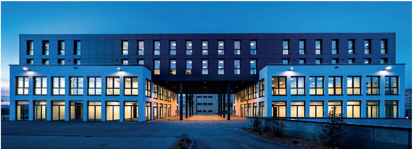
Der Neubau der Büro- und Bildungseinheit „BUBE“ in Koblenz
