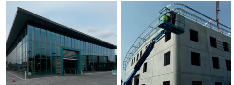
Neubau Carwash Premium Center Errichtung einer Halle mit Büro
