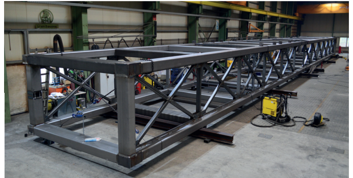
DAS ERSTE VON ZWEI GLEICH GROSSEN BAUTEILEN DER LAUFBRÜCKE (FOTOS: BSH)
