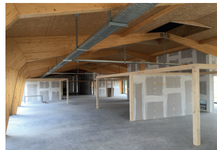
FREI TRAGEND: DER NEUE PROFILSYS FIRMENSITZ ÖFFNET DIE RÄUME FÜR OPTIMALE KOMMUNIKATION (FOTO: HAUSBAU HEGGEMANN)
