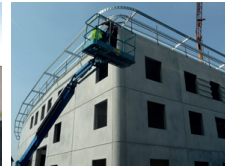
Errichtung einer Halle mit Büro
