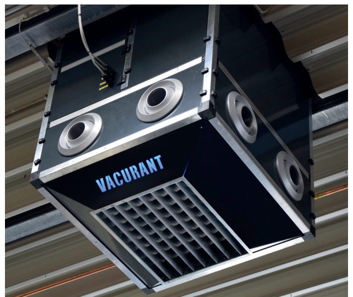
Der Innenteil entlässt die Zuluft durch Luftdüsen mit hoher Reichweite
