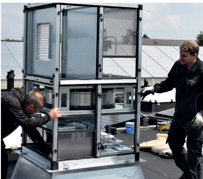
Einbringen des Wärmerückgewinners in die vorbereitete Dachluke
