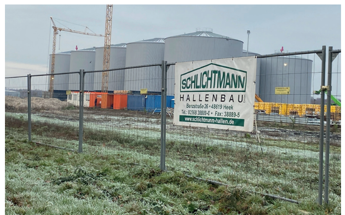
Fotos: Schlichtmann Hallenbau
