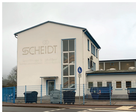
Gebäude vor der Aufstockung
