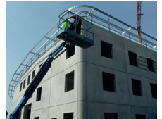
Erichtung einer Halle mit Büro
