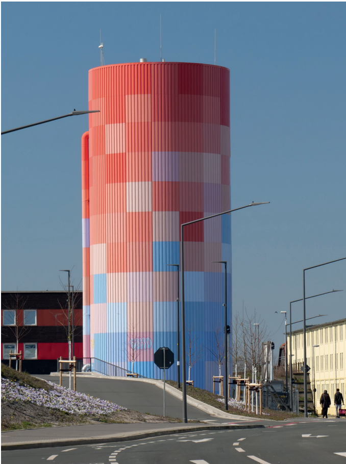
Der Wärmespeicher der Stadtwerke Detmold für ein flexibles Energiesystem mit Zukunft.
