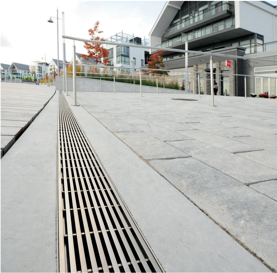
Die Entwässerungsrinnen sind mit reddot-prämierten Designrosten vom Typ Hydra Linearis abgedeckt, welche durch ihre zeitlose Eleganz direkt an die hochwertige Architektur der umliegenden Gebäude anschließen.
