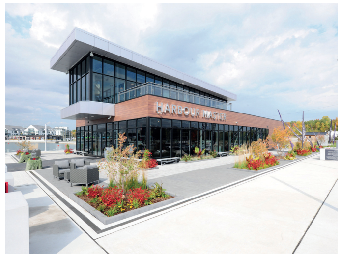
Auch das Verwaltungsgebäude des Hafens wurde mit den Designrosten eingefasst.
