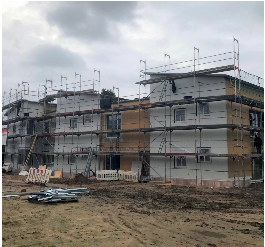
Die Holzwerkstoffplatten wurden außen mit einer rund drei Millimeter starken Putzschicht versehen. Optisch sind die Gebäude von Massivhäusern nicht zu unterscheiden.
