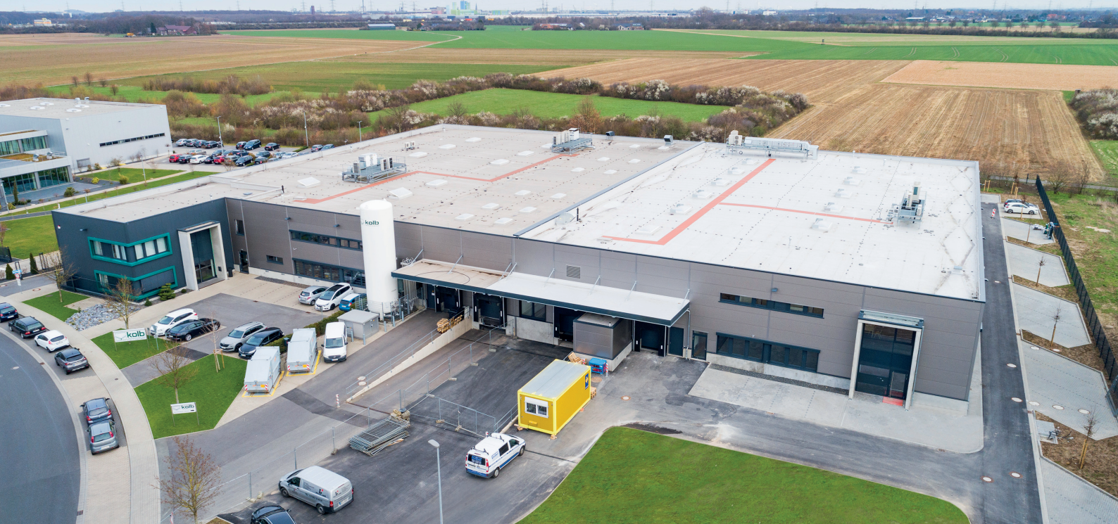
Fotos: Depenbrock Bau GmbH & Co. KG
