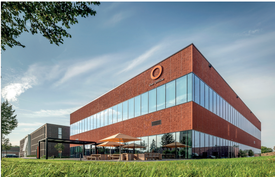
Das Nordhorer Our Office von außen. Es entsteht der Eindruck von vier Geschossen – das ist allerdings eine Illusion, weil jeweils ein umlaufendes Fassadenband aus Klinker und sowie eines aus Fenstern zusammen ein Geschoss einfassen.
