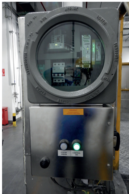
Detail: Steuerung im druckgekapselten Gehäuse
