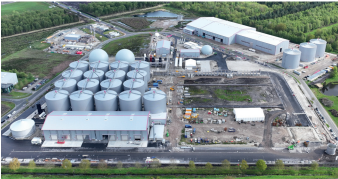
Europas größte Biogasanlage: Die 60-Megawatt-Anlage in Friesoythe setzt neue Maßstäbe in der Produktion von CO 2 -neutralem Biomethan.
