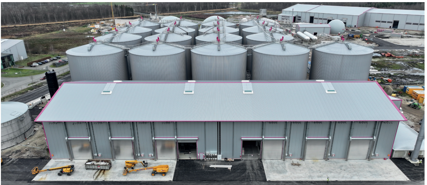
Herausforderungen im Hallenbau: Korrosionsschutz und Abdichtungen sichern die Hallen gegen die Belastungen durch Ammoniak und Schwefel.
