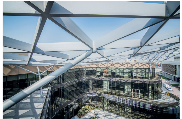
Die in die Glasdachkonstruktion integrierte Textilbespannung FACID ermöglicht eine gezielte Verschattung einzelner Bereiche der Mall.
