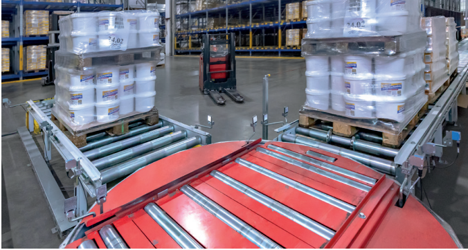
Automatisierte Fördertechnik in Ergänzung und Entlastung der Flurfördertechnik
