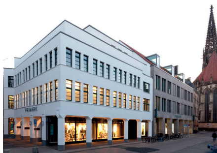
IM HERZEN VON MÜNSTER: KÖSTER REALISIERTE DEN TEILRÜCKBAU UND NEUBAU DES EHEMALIGEN SINN-LEFFERS-GESCHÄFTSHAUSES. (FOTO: KÖSTER GMBH)
