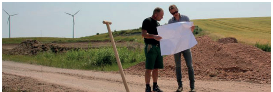
DIE BIOGASANLAGE IN VAHLDORF IST DIE GRÖSSTE EINZELINVESTITION DES SPEZIALISTEN FÜR SCHLÜSSELFERTIGE BIOGASANLAGEN AUS MELLE.
