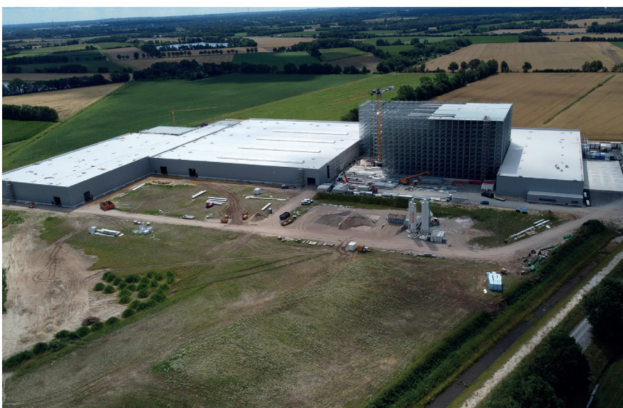
Rückblick Juli 2023 mit Blick auf das 38 m hohe Hochregallager.
